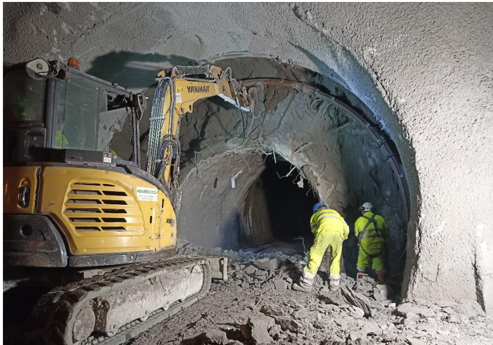
Ejecución de galería de emergencia en el túnel de Barrios
