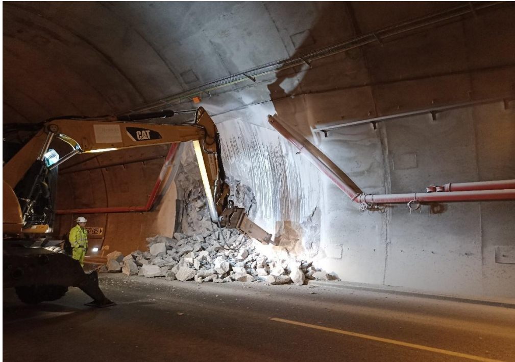
Ejecución de galería de emergencia en el túnel de Negrón
